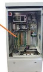
Abbildung 6 – Steuerzentrale der LSA, welche hinten in dem Schuppen Abbildung 4 verbaut ist
