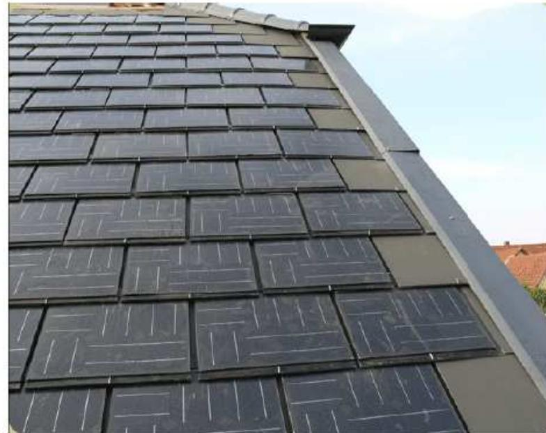
*mit Kunststoff statt Glas (extrusion coating) wird der solar roofing slade leichter, bruch sicher und billiger.*
