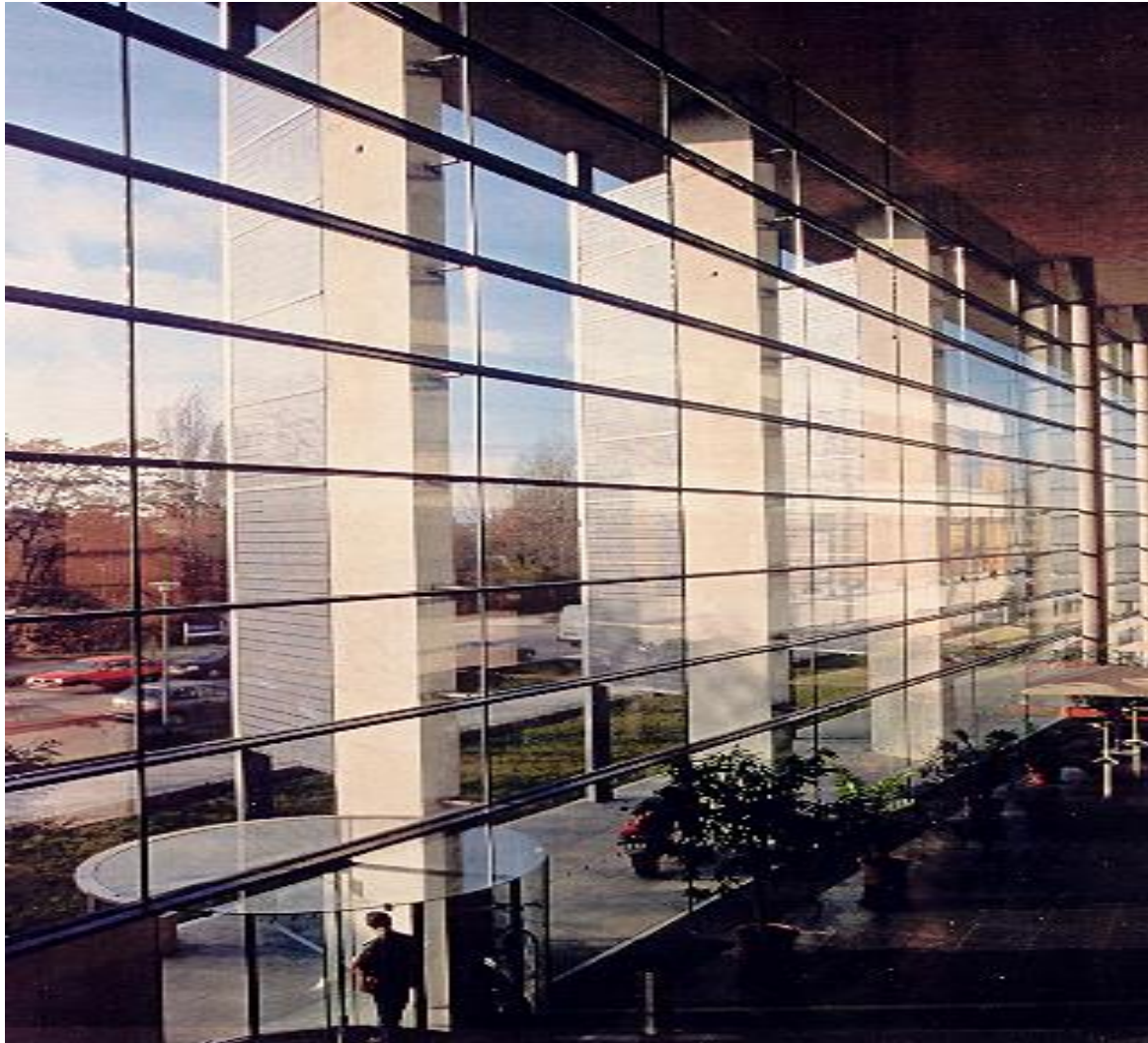
UTZ, Volmerstraße. Blick von Innen auf die PV-Fassade
