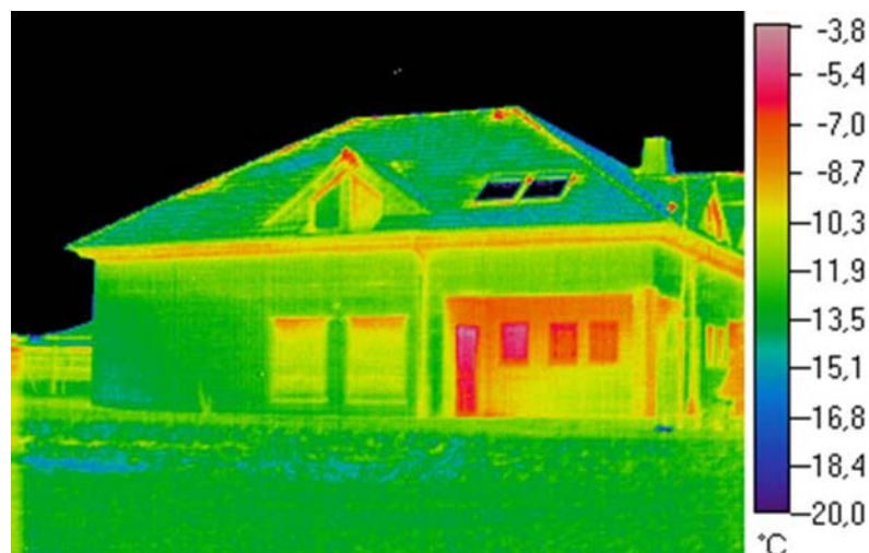
Abb. 2: Thermobild eines Hauses
