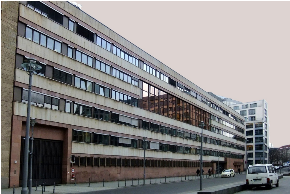
ZKI-Hauptgebäude Berlin, Kurstraße 33 (Foto des Autors)
